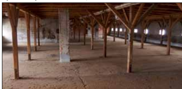
Horní patro vedlejší budovy navazující na budovu hlavní.
