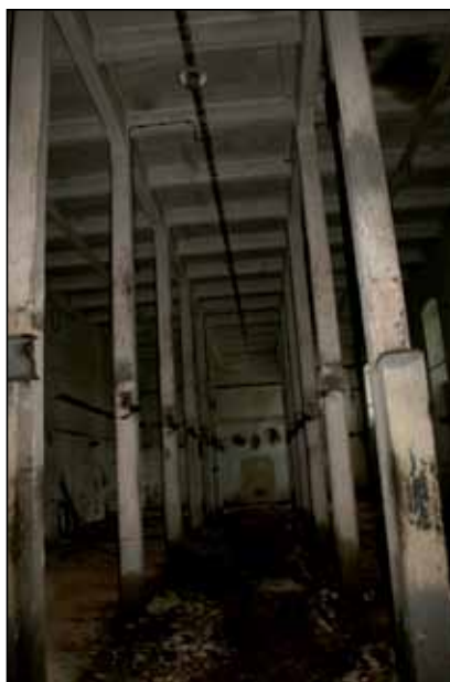
Skladovací prostor v části hlavní budovy.
