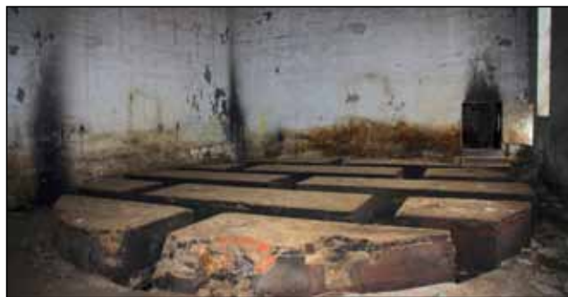
Interiér jedné z místností samostatného zbytkového skladu (piloty pro nádrže).
