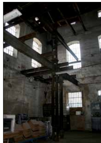
Zbytky konstrukce horní strojovny nákladové zdviže v hlavní budově.
