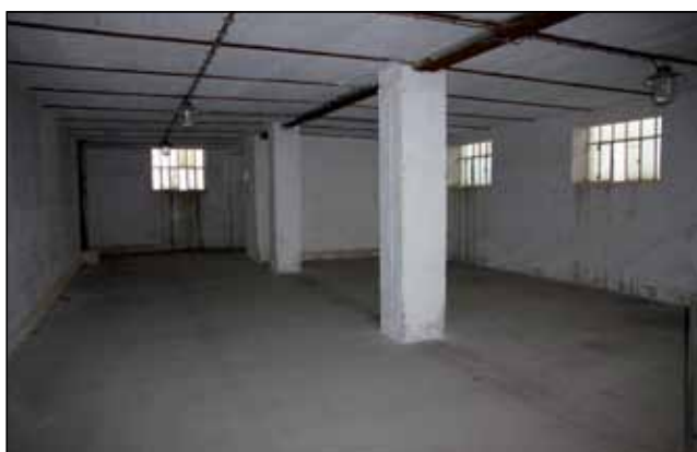
Vrchní patro v části hlavní budovy.
