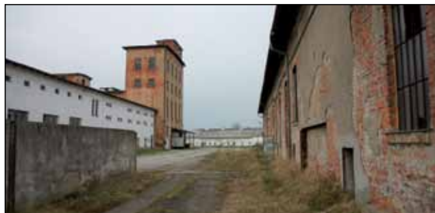
Pohled na hlavní manipulační plochu směrem od již zbouraného samostatného zbytkového skladu. Uprostřed hlavní budova.
