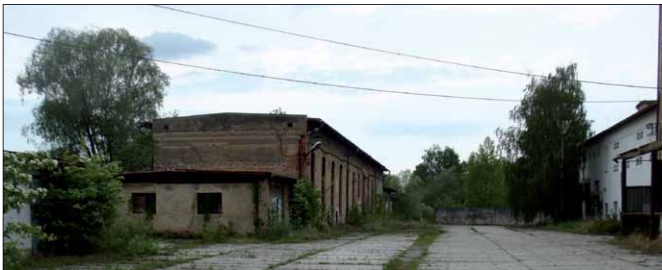
Pohled na hlavní manipulační plochu při vstupu do areálu.
