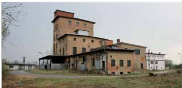
Pohled na areál ze severní strany.
