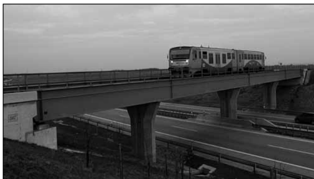
Největší technickou stavbou na bílovecké trati se v roce 2007 stal nový ocelový most délky 70 m přes dálnici D1. Přes most přejíždí Regionova 814/914.023 na spoji do Bílovce. Foto P. Hrudíčka, 28. 3. 2011.
