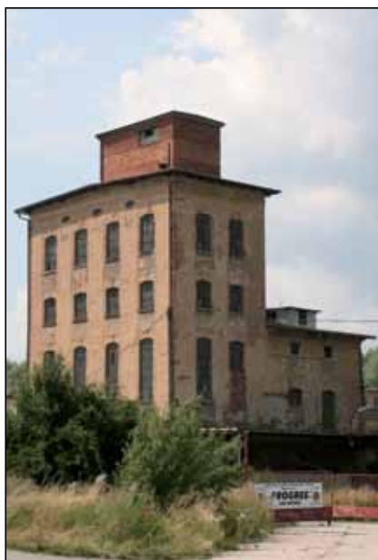
Celkový pohled na hlavní budovu.
