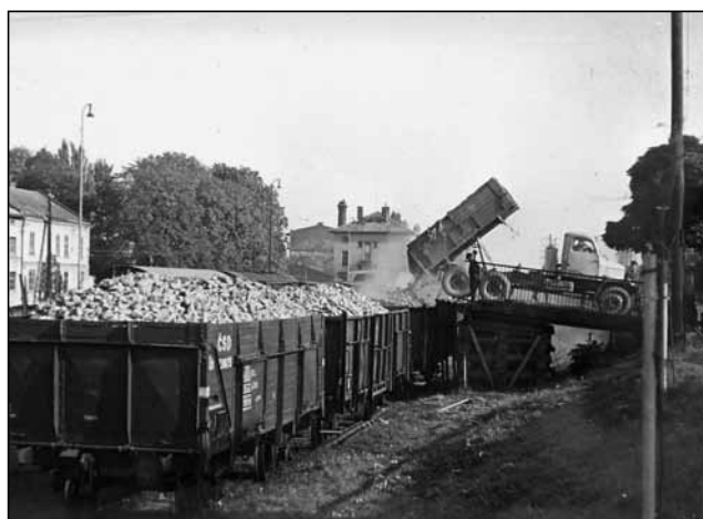
Snímek z přelomu 50. a 60. let ukazuje zajímavou nakládací rampu, vybudovanou v Bílovci pro nakládku cukrovky do železničních vozů. Rampa využívala převýšení Budovatelské ulice nad úroveň kolejí. Zdroj: foto Jestřibek, sbírka M. Leštinský.
