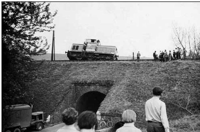
Vykolejení osobního vlaku na nadjezdu u Velkých Albrechtic 9. května 1967 se naštěstí obešlo bez vážných následků. Snímek ukazuje přípravy nakolejení lokomotivy T334.0088, osobní vozy vlaku jsou již odtaheny. Akce probíhala za velkého zájmu okolních obyvatel. Na snímku je také vidět viadukt, kterým se poslední dobou dostává do centra pozornosti s ohledem na spory o jeho budoucnost. Zdroj: Sbírka M. Leštinský.
