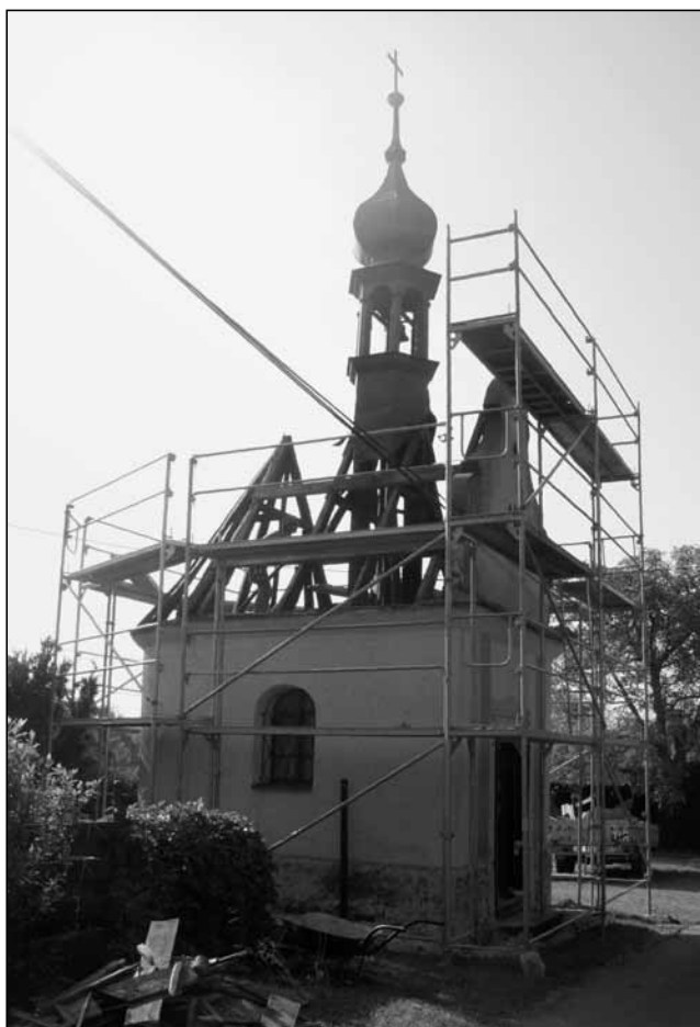
Kaple od severozápadu během opravy, 2014. Foto autorka.
