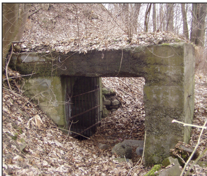
Odrá, protiletectvý bunkr
