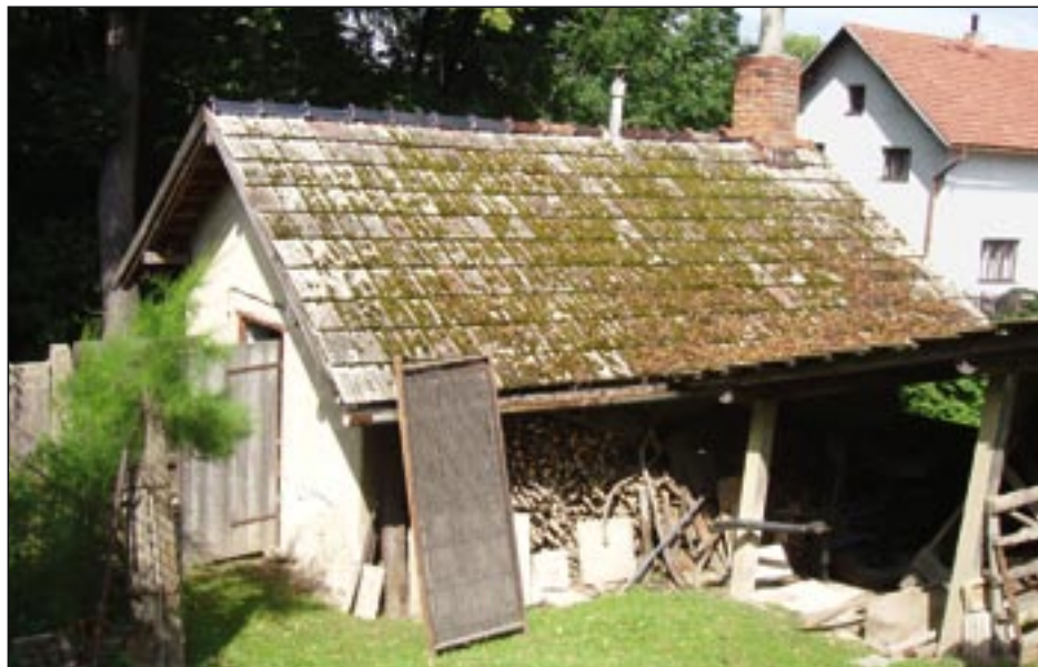
Stará sušárna ovoce u Dreslerů v Bernarticích nad Odrou; v současnosti je mimo provoz. O střechu je opřena lésa na níž se ovoce sušilo.
