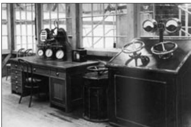
Přístrojový sál zkušebny ve Fischamendu.
