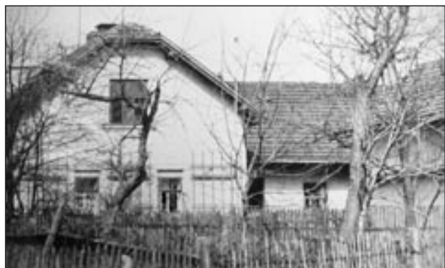
Dům čp. 1 patřil Antonii a Františkovi Venclíkovým.
