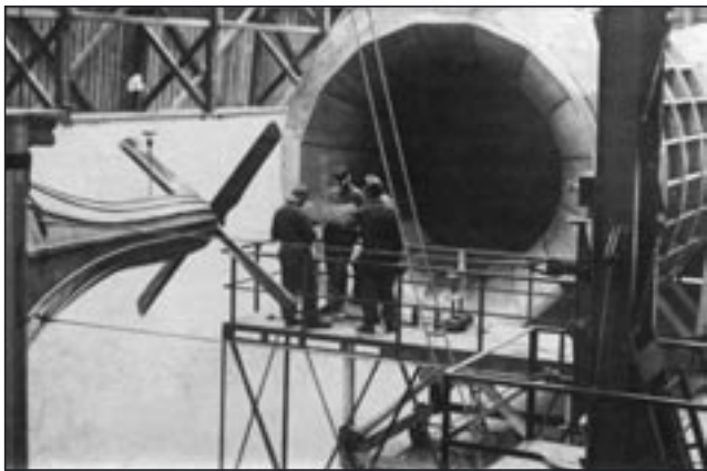
Zkušebna vrtulí ve Fischamendu, přebudovaná z hangáru, který byl původně určen pro vzducholoď. Na můstku ve stejnokroji je hejtman (kapitán) Ing. Vilém Žurovec.
