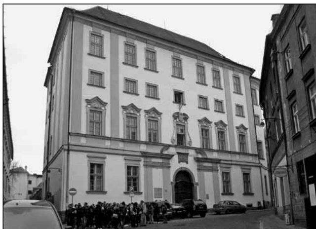
Olomouc 2013. Budova bývalého Medicínsko-chirurgického ústavu na Univerzitní ulici. Foto Milan Tichák.
