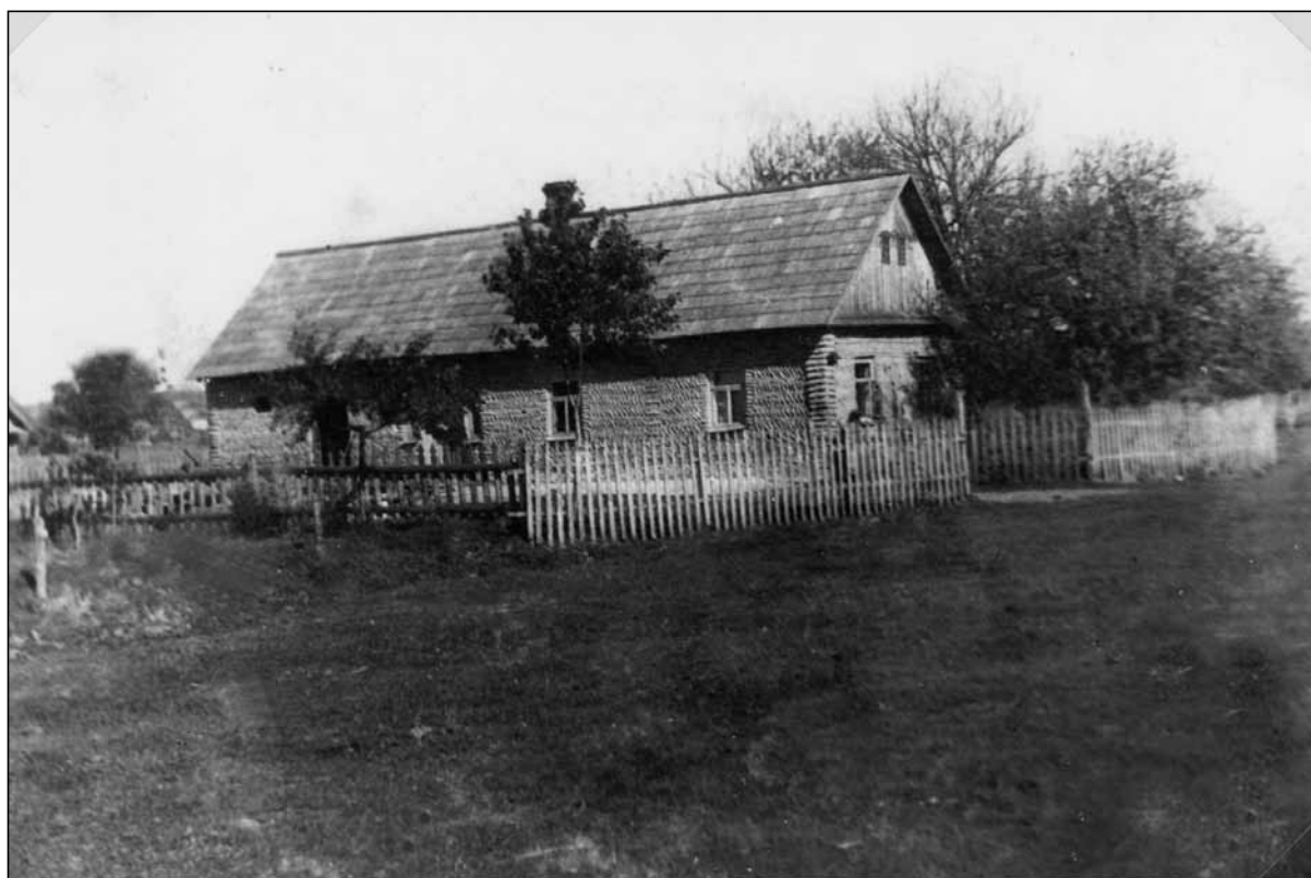
Stavení Růženy Kubové na Plosce v roce 1943.
