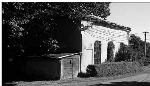
Dvořisko, usedlost čp. 81. Pohled na taneční sál bývalého hostince. Část verandy byla přestavena na garáž. Foto Emil Mateiciuc, 2012.
