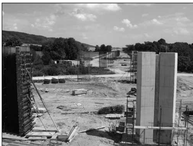
Ze stavby dálnice D 47 – estakáda přes oderské údolí pod Odrami (Foto Radim Jarošek, srpen 2007).
