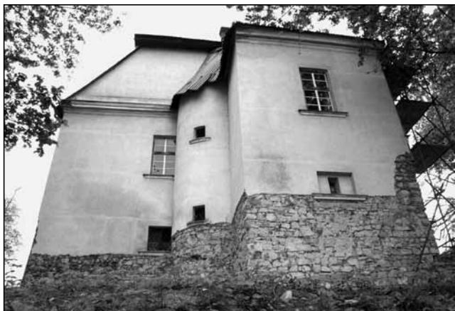
Severovýchodní průčelí zámku, foto 2008.
