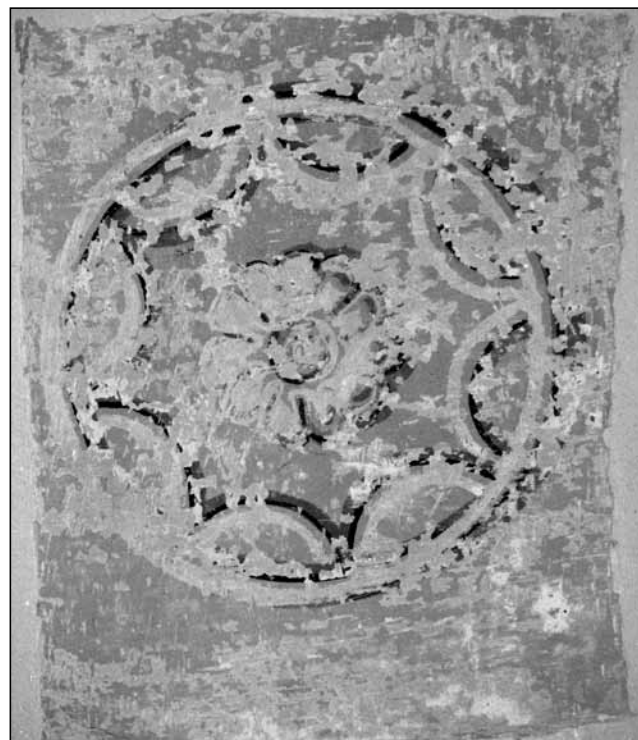
Středová výzdoba klenby nad podestou schodiště na půdu (1. pol. 19. století?), foto 2008.
