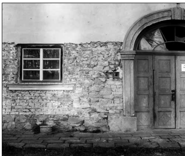
Situace na jihovýchodním průčelí zprava doleva: kamenný portál na otočené staré stojce, barokní zdivo z cihel a kamene z roku 1728, klasicistní zdivo z roku 1822/23, foto 2008.
