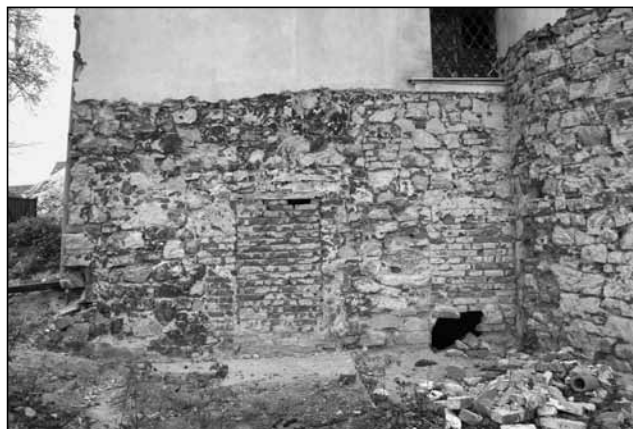
Dva zazděné vstupy na severovýchodním průčelí zámku, foto 2008.
