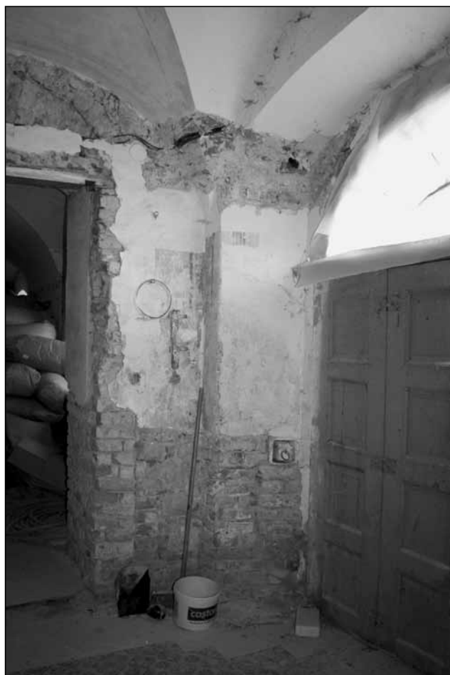
Východní roh průjezdu 101 se závorou a výběhem klenby, v rohu a na výběhu malovaná historizující výzdoba, foto 2008.
