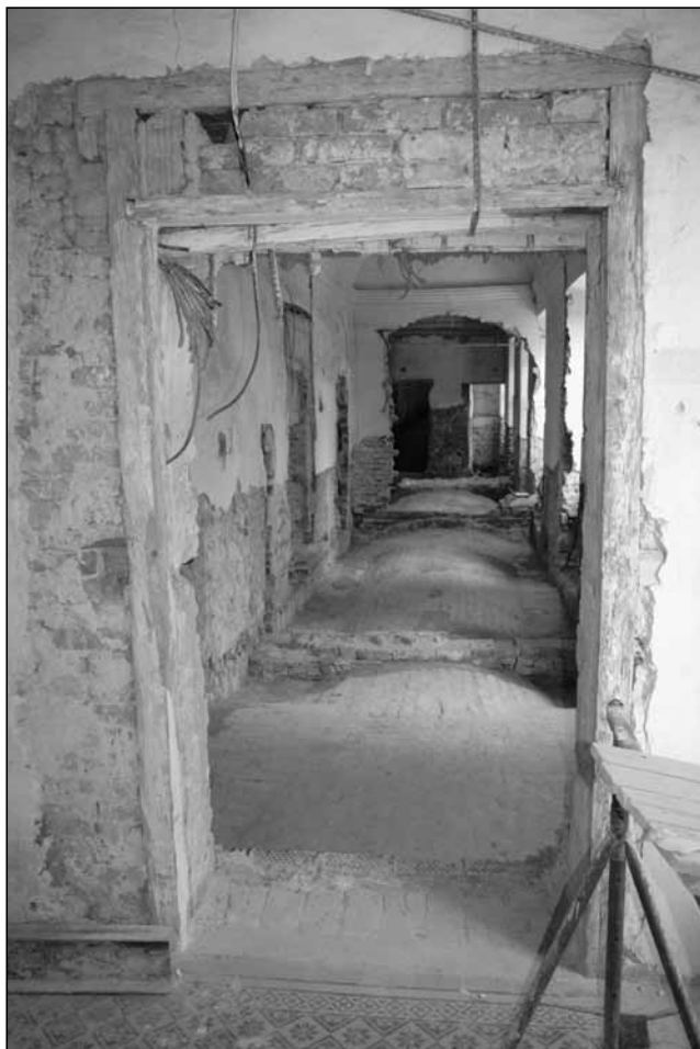
Zárubeň se zazděným nadsvětlíkem z haly 201 do chodby 202, foto 2008.
