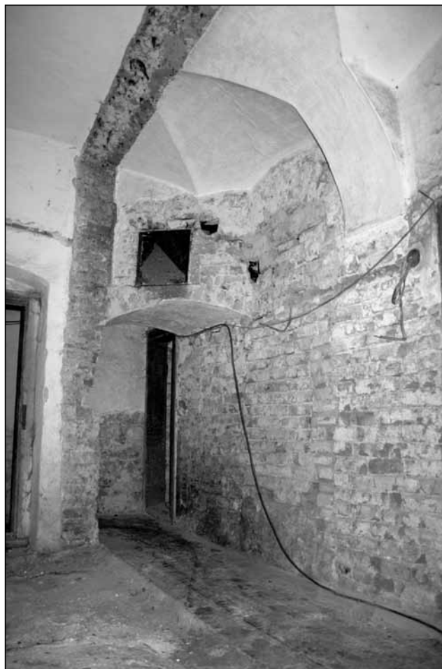
Západní roh místnosti 106 a 111, kam byl pod klenbu vsazen podklenutý sopouch pro odvod kouře, foto 2008.
