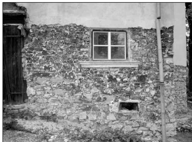
Zdivo staré tvrže očištěné lokálním požárem ve východním nároží zámku, foto 2008.
