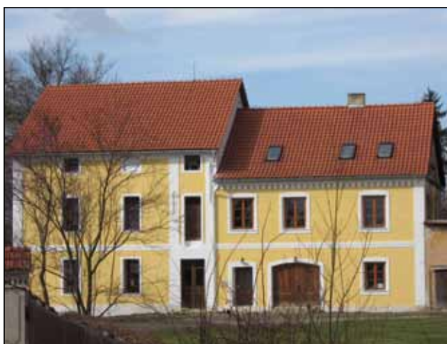
Bartošovický mlýn. K typickými stavbám umístěvaným do nivy řeky Odry patříly vodní mlýny.
