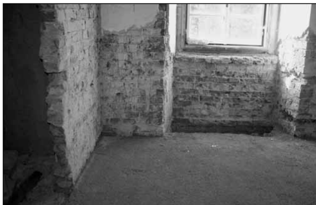
Západní roh místnosti 209, v úrovni podlahy jsou viditelné kapsy po uložení dřev ztužujícího věnce, foto 2008.
