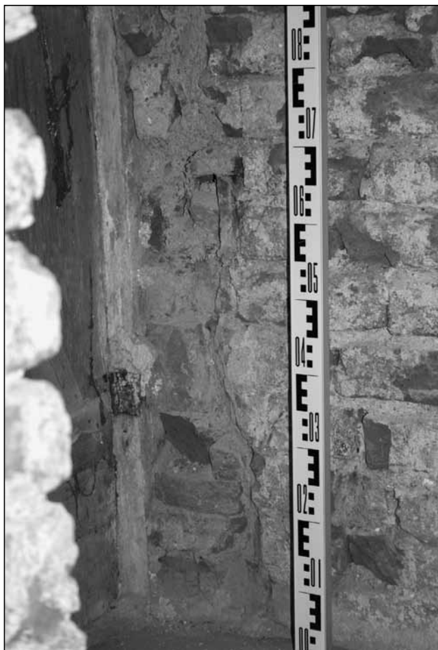
Zazdívka závorové kapsy v jižní bočnici prostupu ze 109 do přízemí věže 110, foto 2008.
