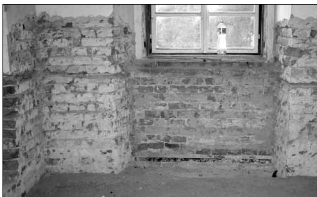
Severozápadní zeď se ztužením pásovinou v klasicistní části zámku, foto 2008.
