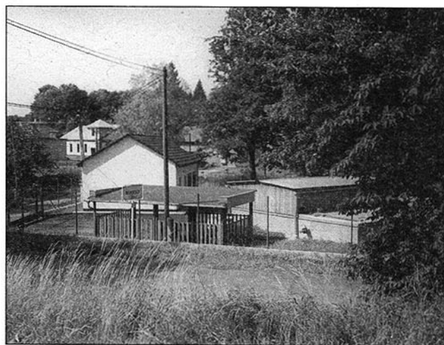
Čistírna odpadních vod v Bernarticích n.O. (foto: R. Jarošek)
