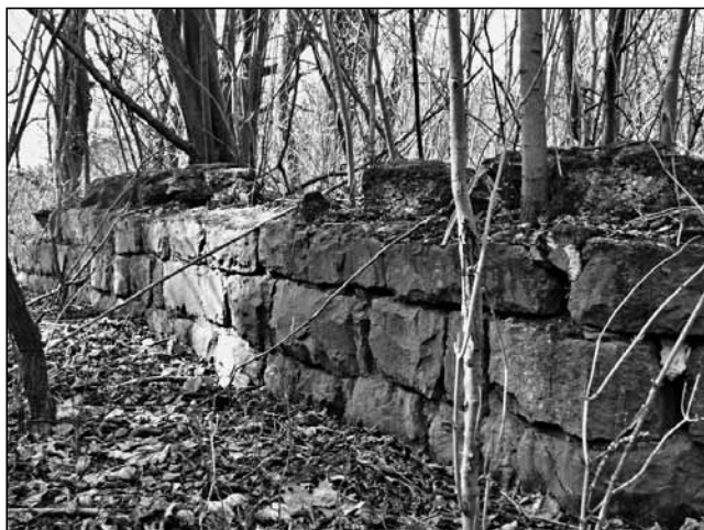
Zbytek základů tanečního sálu v roce 2015 (Foto Jiří Kucharz).
