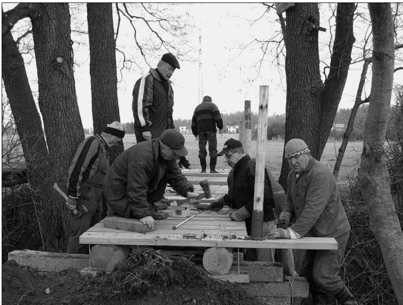
Stavba lávky Dalibor.
