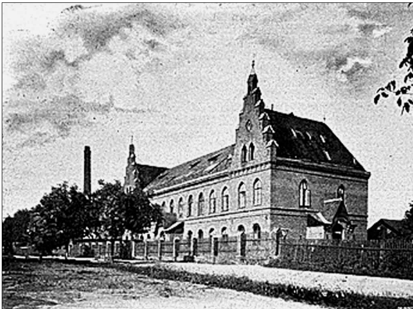
Odry 1873. Hlavní tovární budova firmy Schnek & Kohnberger u cesty do Louček (bývalá Vodní ulice). Archiv Muzejního spolku Rolleder – Odry, o. p. s.
