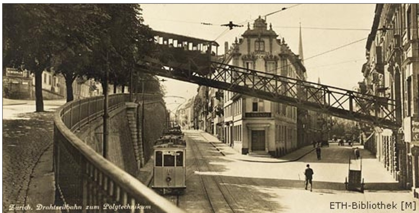
Curych 1900. Lanová dráha "Polybahn" z ETH (Polytechnikum) do Limmatqualu. Úsek tratě vedený po mostní konstrukci v ulici Curychu. Hlavní parametry lanové dráhy: délka 176m, převýšení 41m, stoupání 23%, rozchod 955mm, rychlost jízdy 2,5m/sec. ETH-Bibliothek Curych
