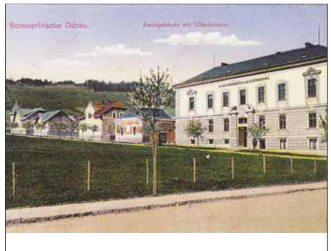
25 Odry, budova soudního okresu Odry na Sokolovské ulici
